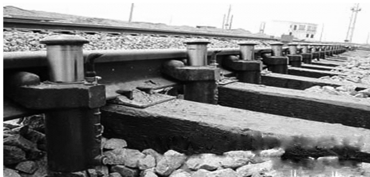
图 1.2.12 减速顶安装位置
